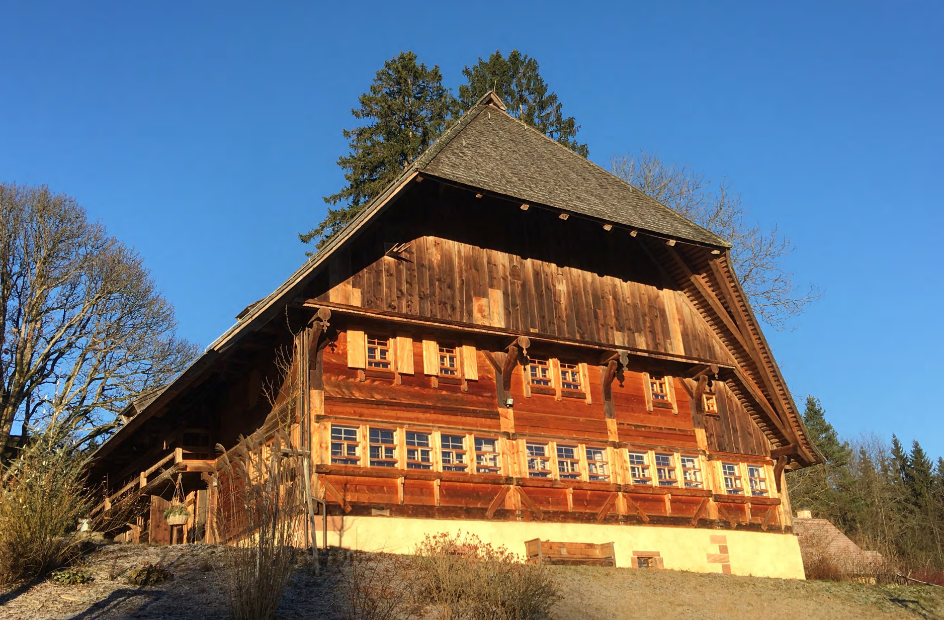
Der Hintere Liefersberger Hof, Wolfach-Kirnbach: Ostfassade
