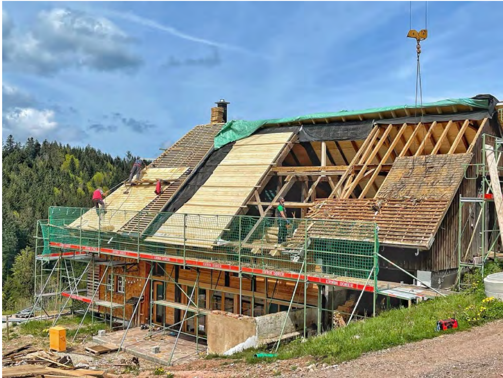
Ganterhäusle, Gütenbach, um 1750, Phasen der Dachsanierung
