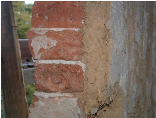
6. Durch den dicken, raumseitigen Lehmputz wurde der Dämmwert der Ziegelwand optimiert.
