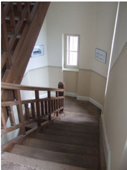
30. - 31. Im Treppenhaus des ehemaligen Bahnhofgebäudes war eine Innendämmung nicht möglich, gedämmt wurden daher raumseitig die Innenwände zum Treppenraum.
