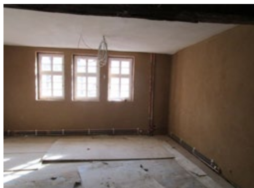
47. Ein Lehmputz mit Anstrich bildet den Abschluss der kapillaraktiven und diffusionsoffenen Innendämmung, die Heizungsrohre wurden auf Putz verlegt.
