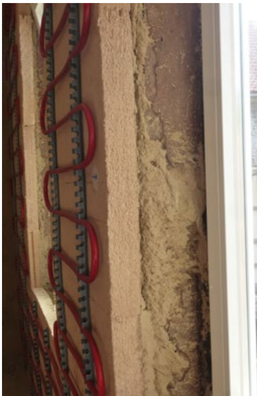
24. - 27. kapillaraktive Innendämmung mit Mineralfüllplatten, Wärmedämmlehm, Holzweichfaserplatten und Leichtlehmsteinen
