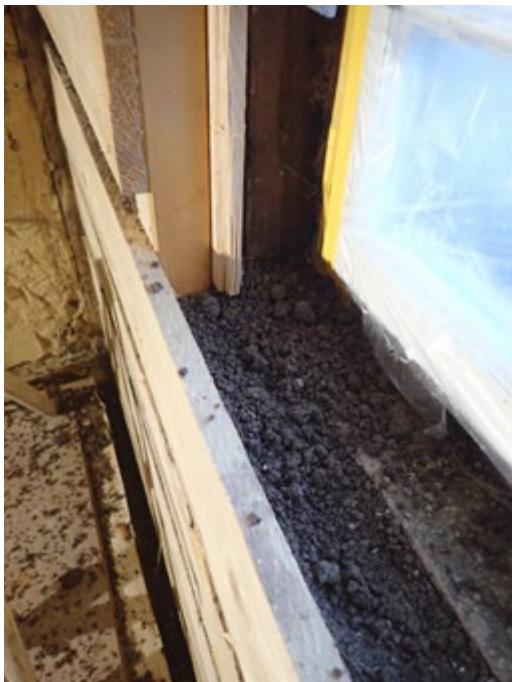
45. Der Wärmedämmlehm wird schichtweise eingebracht und verdichtet, die Trocknungszeiten des Wärmedämmlehms sind im Bauablauf zu berücksichtigen.
