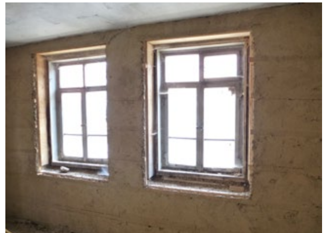
20. Plastisches Dämmsystem mit Wärmedämmlehm
