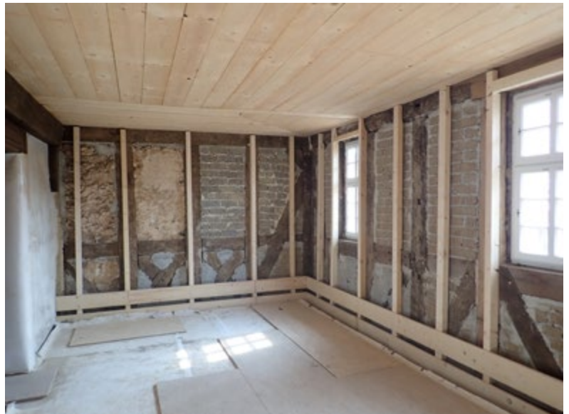
44. Ausführung einer kapillaraktiven Innendämmung mit Wärmedämmlehm, Vorbereitung der Wand und Unterkonstruktion
