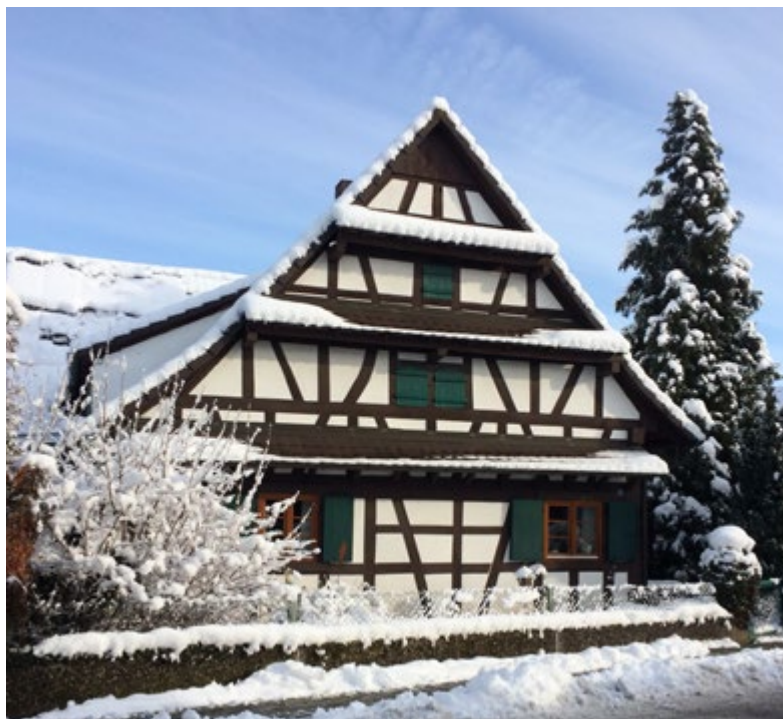
13. Konstruktiver Schlagregenschutz durch geschossweise angebrachte Vordächer in Baden
