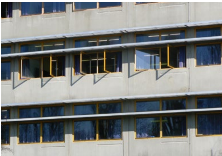
33. Fassade aus Stahlbetonfertigteilen
