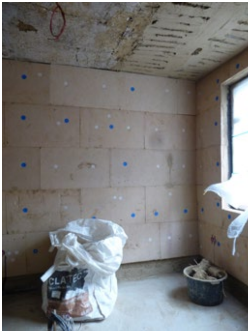
49. Für eine hohlraumfreie Ausführung ist eine ebene Wand erforderlich und ggfs. durch Ausgleichsputz herzustellen.
