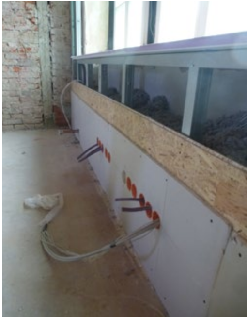
37. Innendämmung mit Ständerwerksystem in Leichtbauweise
