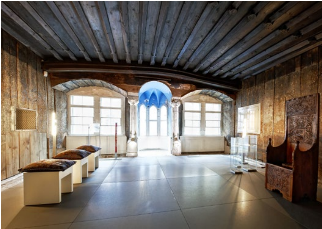
5. In einer Bohlenstube dienten Decken- und Wandbekleidungen aus Holz der Wärmedämmung und Behaglichkeit im Raum.
