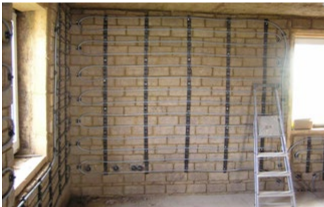
19. Gemauerte Vorsatzschale mit Leichtlehmsteinen
