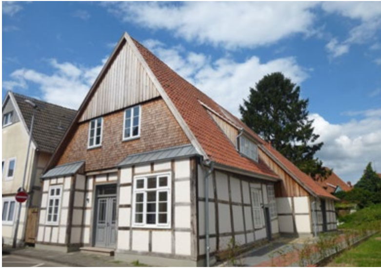
48. Das Fachwerkhaus wurde mit Holzfaserplatten innen gedämmt, um das äußere Erscheinungsbild zu erhalten.
