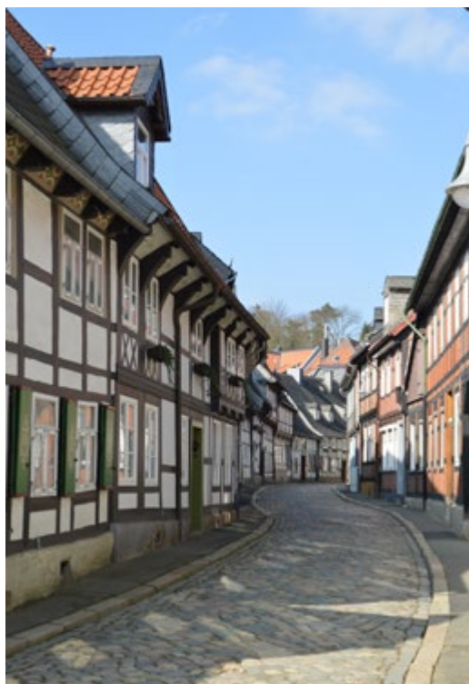
1. Um die Fachwerksichtigkeit und das regionaltypische Straßenbild zu erhalten, ist eine Außenwärmedämmung nicht möglich.
