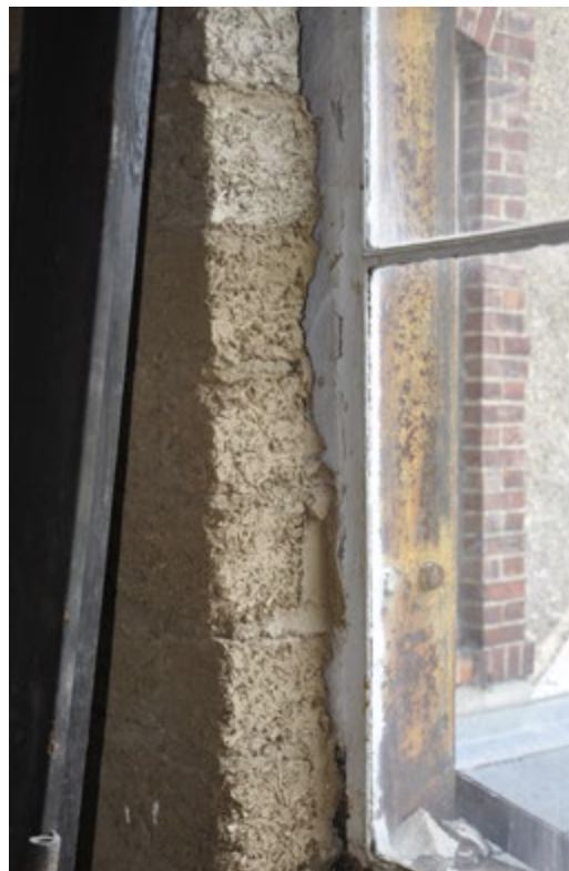
24. - 27. kapillaraktive Innendämmung mit Mineralfüllplatten, Wärmedämmlehm, Holzweichfaserplatten und Leichtlehmsteinen
