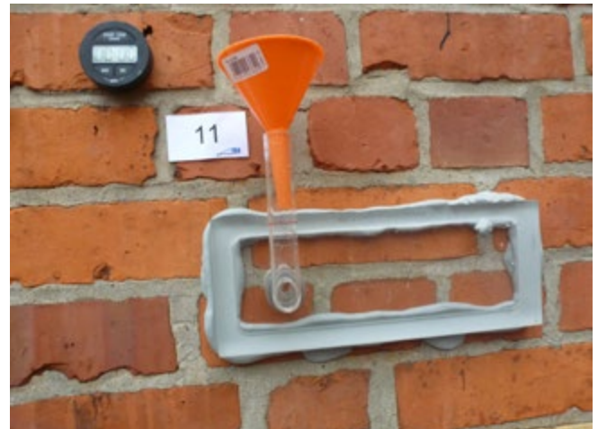
35. Örtliche Schlagregenuntersuchung mit der Franke-Platte
