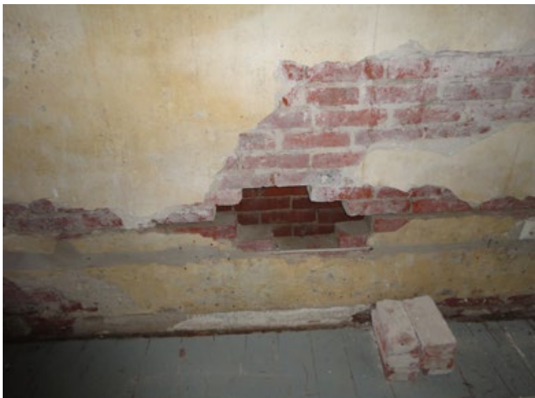
34. Zweischaliges Mauerwerk mit Hohlschicht
