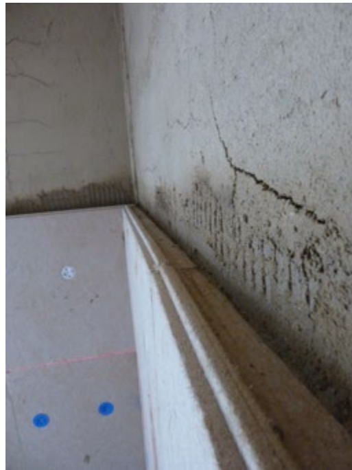
50. Nach Montage der Holzfaserplatten wird der abschließende Lehmputz aufgetragen.
