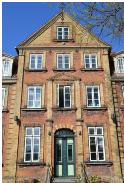
2. Eine Außenwärmedämmung würde den Verlust dieser detailreichen und denkmalwerten Ziegelfassade bedeuten.
