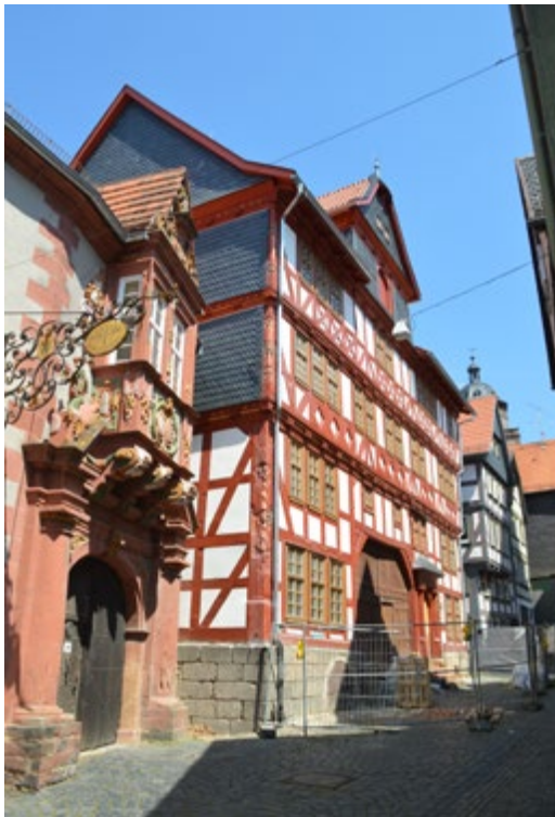
43. Die Fachwerksichtigkeit konnte durch die Ausführung einer Innendämmung erhalten bleiben, Schlagregenschutz am Westgiebel durch Schieferbehang.
