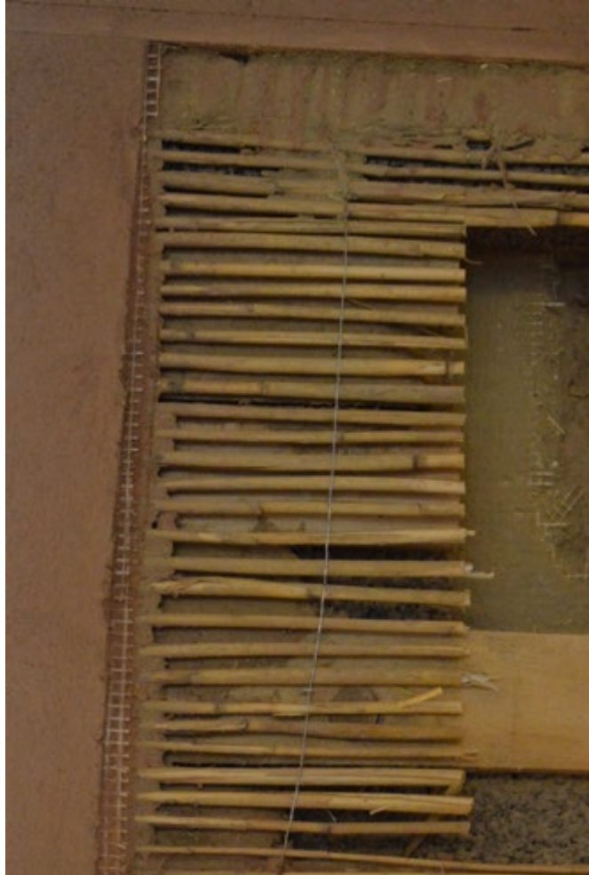
Kapillaraktive Innendämmung mit Minerldämmplatte, Leichtlehm und Holzfaserplatte
