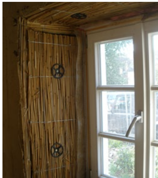
40. Innendämmung der Fensterlaibung mit Schilfrohr
