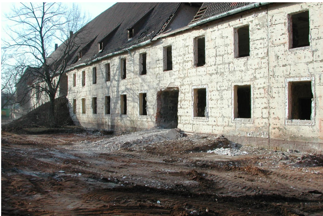
Abbildung 5: Vollständig entferntes WDVS beim Rückbau von Kasernengebäuden.
